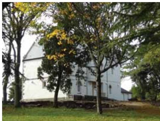
Façade Nord-Est, vue du parc nettoyé des gravas et équipements du chantier.
