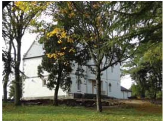
Façade Nord-Est, vue du parc nettoyé des gravas et équipements du chantier.
